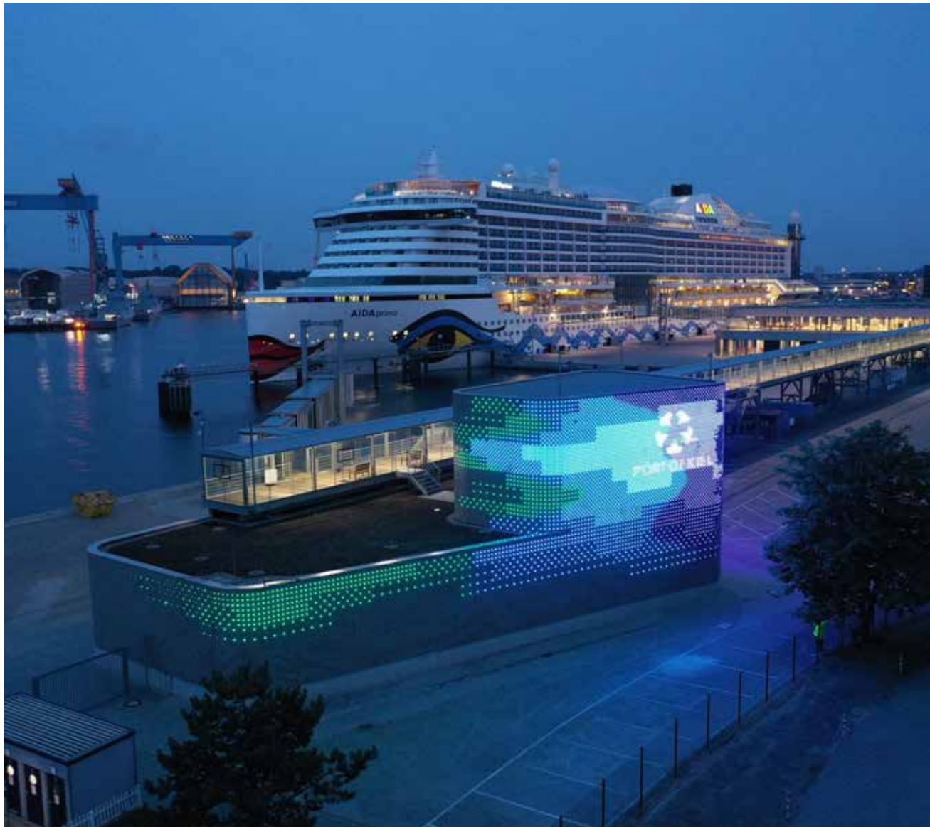
Kreuzfahrtschiff mit Landstromanlage in Kiel
