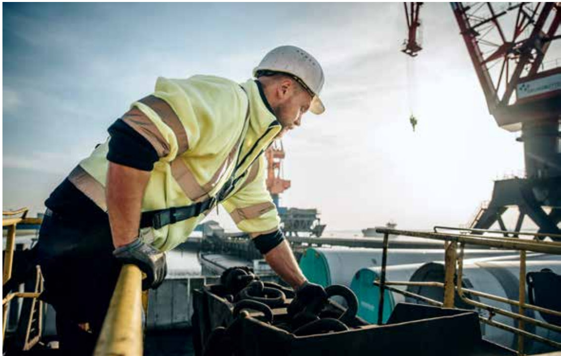
Arbeiten im Elbehafen Brunsbüttel
